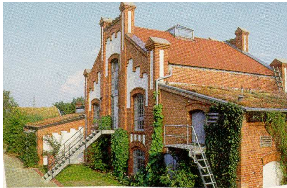
Beispiel einer Wiederaktivierung von Altbausubstanz Archi Nova-Umbauprojekt Altes Gaswerk, Bönningheim
