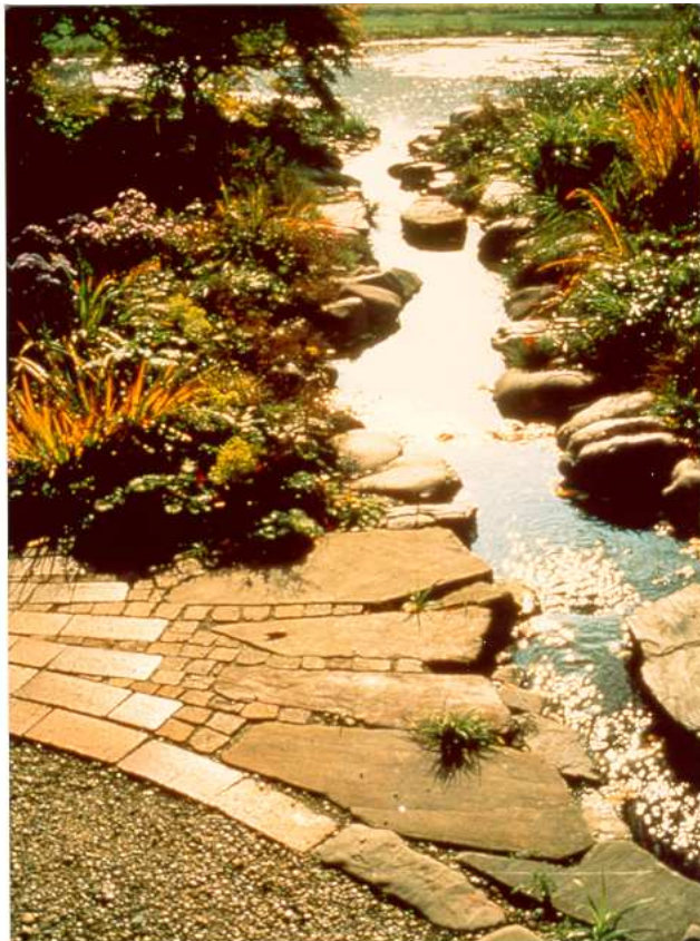
Regenwasser wird durch offene Mulden und Gräben kunstvoll gestalteten Rinnen oberflächlich abgeleitet,
